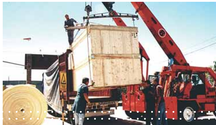
MOVIMIENTO DE CONTENEDORES EN PLAYA DE CARGA Y DESCARGA / CONTAINER MOVEMENT AT THE LOADING AND UNLOADING LOT
