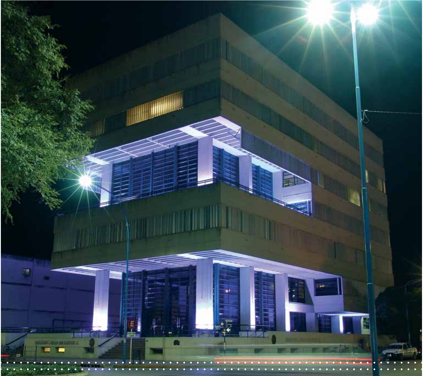
EDIFICIO DE LA MUNICIPALIDAD DE RAFAELA / RAFAELA'S CITY HALL
