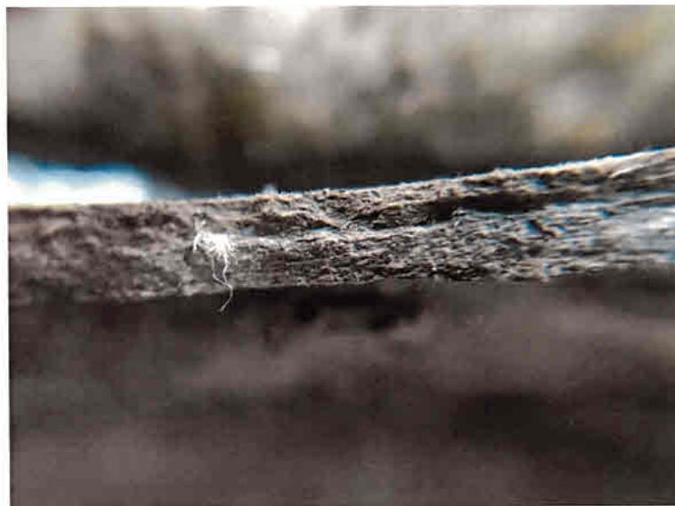
Figura 7: Vista del corte de la capa de cubierta (se observan fibras)
