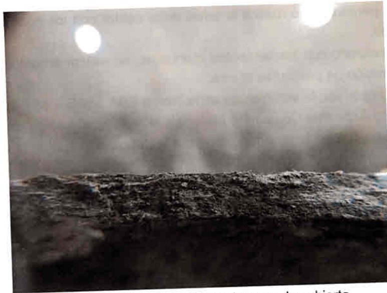
Figura 12: Vista del corte de la capa de cubierta
