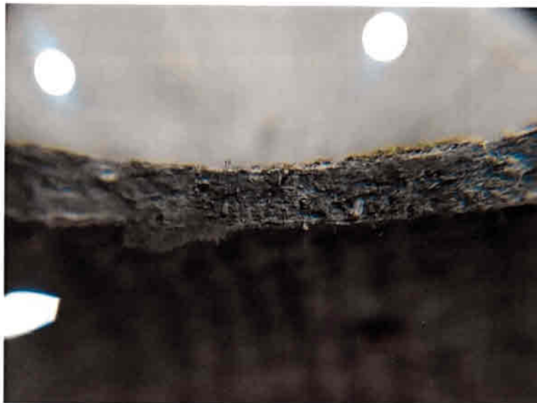
Figura 10: Vista del corte de la capa de cubierta (se observan fibras)
